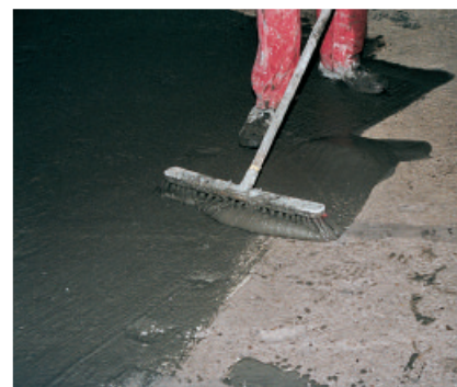
PCI Repahaft wordt op de ondergrond geborsteld. De dekvloer wordt meteen daarna op de verse hechtbrug aangebracht.
