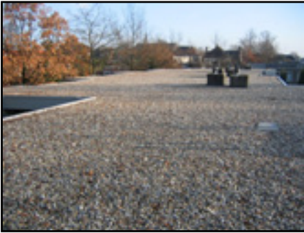
Huissen: Geballast systeem met grind
