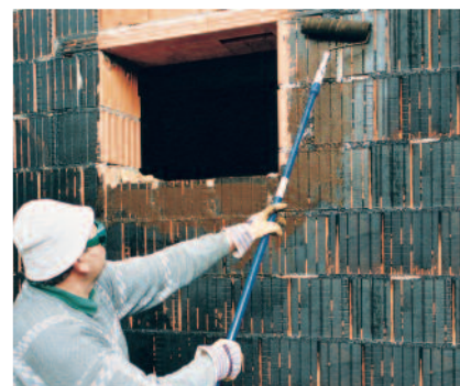
PCI Pecimor F, 1 : 5 met water verdund, als grondering voor bitumenafwerklagen.
