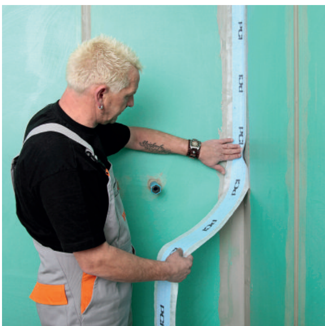
3. PCI PECITAPE 120 of PCI Kimband met PCI LASTOGUM (grijs) in de hoek- en wand/vloeraansluitingen lijmen.
