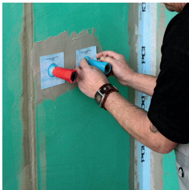
2. PCI PECITAPE 10 x 10 over de uit de wand stekende leiding schuiven en met PCI LASTOGUM (grijs) verlijmen.
