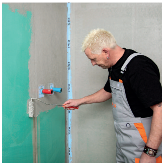
4. De eerste afdichtingslaag PCI LASTOGUM (grijs) onverdund vol en zat met volledige dekking aanbrengen.
