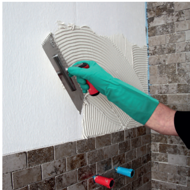
6. Na droging van PCI LASTOGUM kunnen tegels of platen worden verlijmd.
