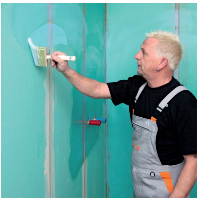
1. Zuigende minerale en gipshoudende ondergronden en gipsplaten met PCI GISOGRUND gronderen.
