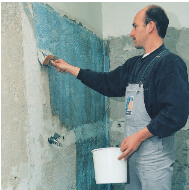
PCI Gisogrund verbetert de vastheid en draagkracht van oude, afzandende pleisters en verhoogt de hechting van tegels, pleisters en behang.
