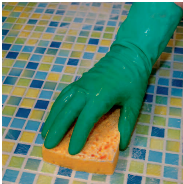
Wassen van het gevoegde oppervlak met een fijne epoxyspons.
