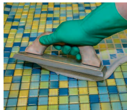
Met PCI Durapox NT en PCI Durapox NT plus kan mozaïek chemicaliënbestendig en waterondoorlaatbaar gevoegd worden.
