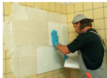
Het verlijmen van wandtegels met PCI Bicolit Extra op oud keramiek.
